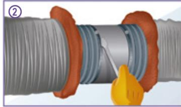
2.- Cubra los núcleos con al menos dos vueltas de cinta para ducto. Asegure con dos abrazaderas.
